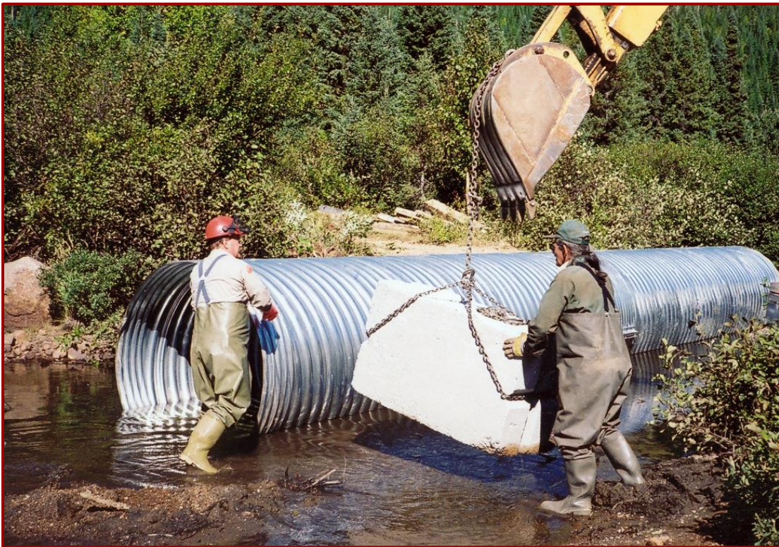
Figure 1 : Installation d’un ponceau.
