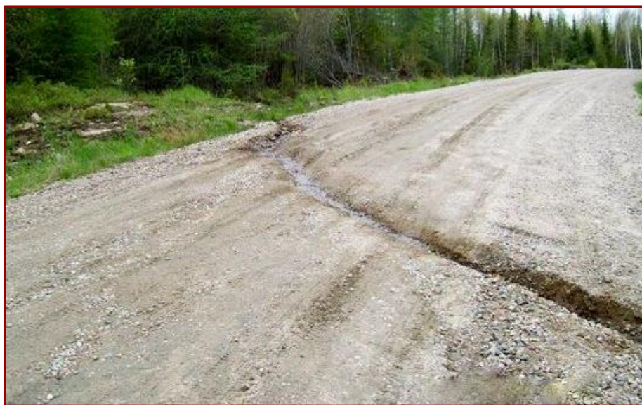
Figure 18 : Érosion causée par le ruissellement de l'eau sur la chaussée (zec Mitchinamécus).
