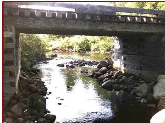
Figure 10 : Pont de bois.
