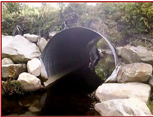
Figure 13 : Ponceau à structure fermée.
