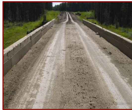
Figure 12 : Surface de roulement continue
