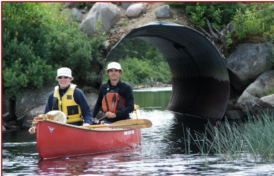
Figure 7 : Cours d'eau à écoulement permanent.
