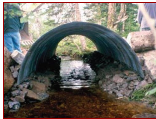
Figure 14 : Ponceau à structure ouverte.
