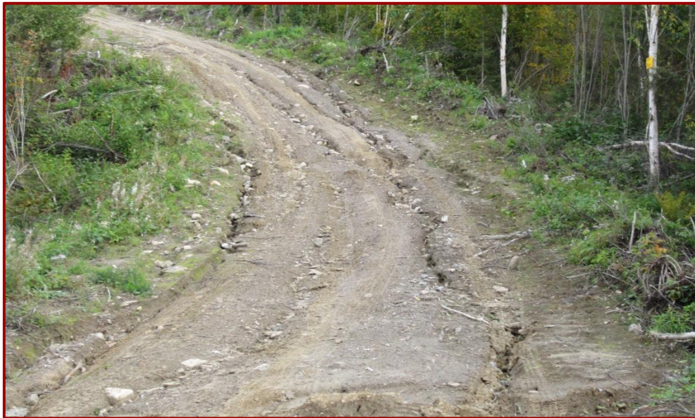
Figure 3 : Dégradation d'un chemin dans la zec Mars-Moulin.
