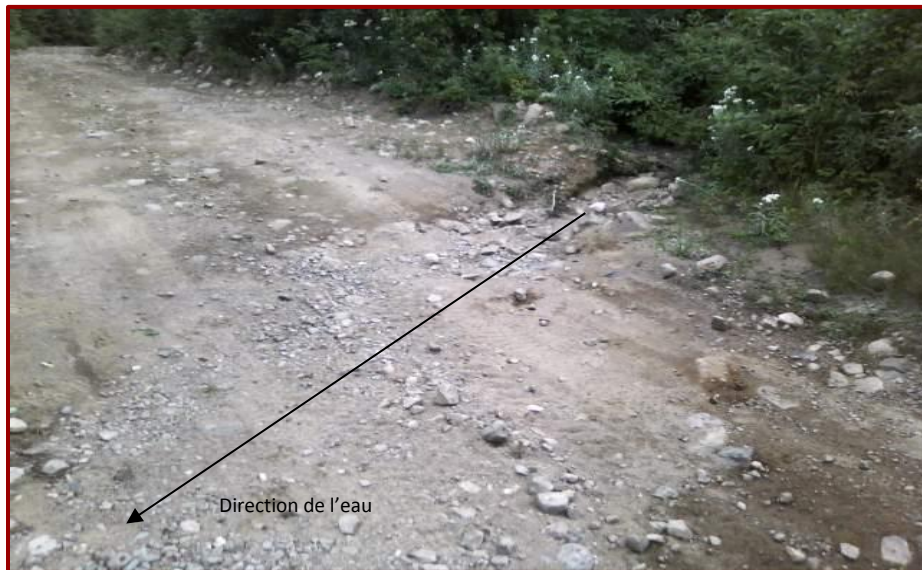
Figure 17 : Érosion causée par le ruissellement de l'eau sur la chaussée.
